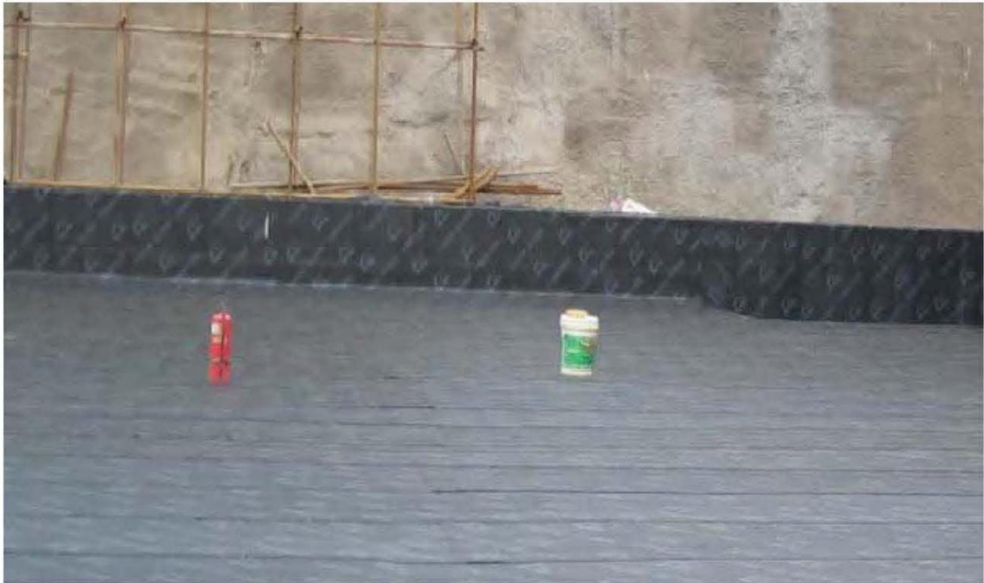
图5-24 沥青基聚酯胎防水层现场施工照片
