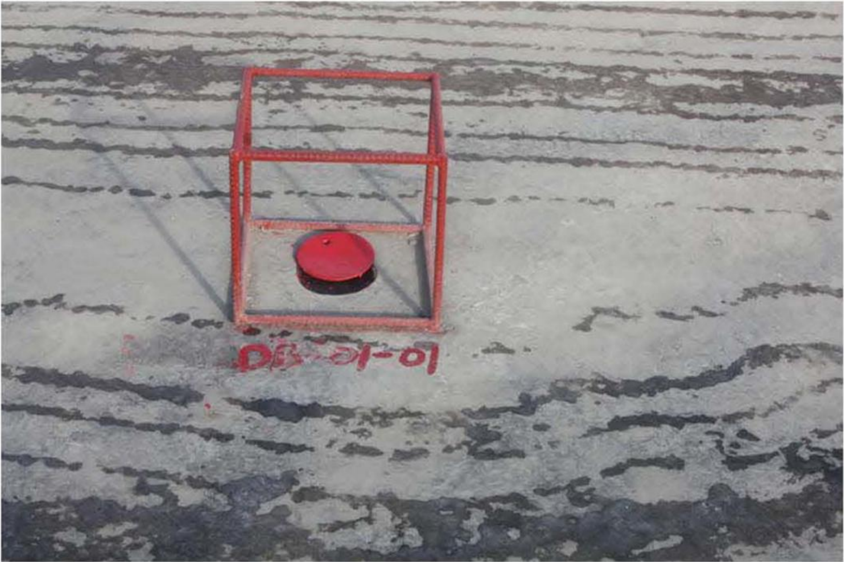
图4-10 监测点埋设于保护现场照片
