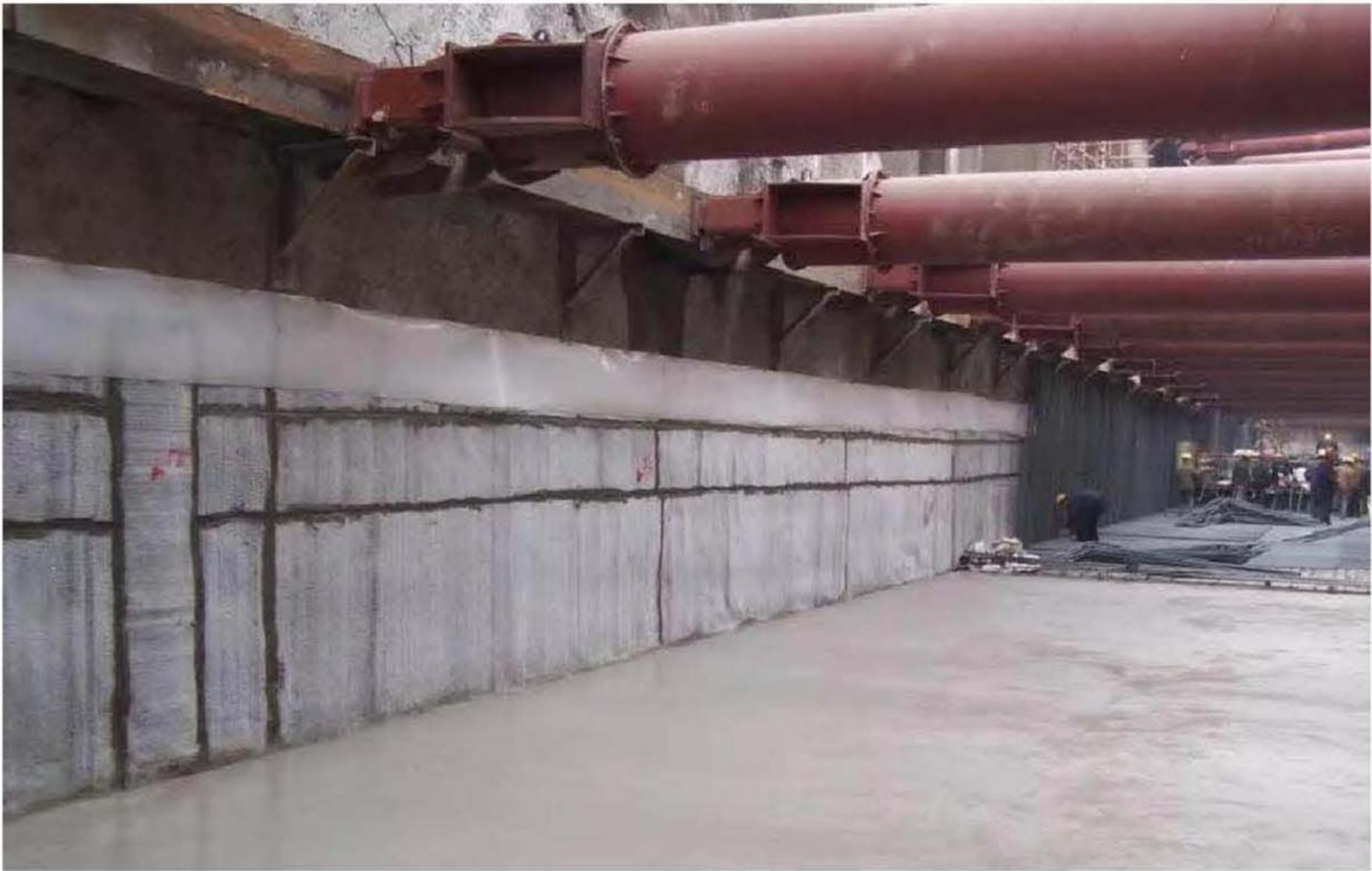
图5-8 膨润土防水层现场施工照片
