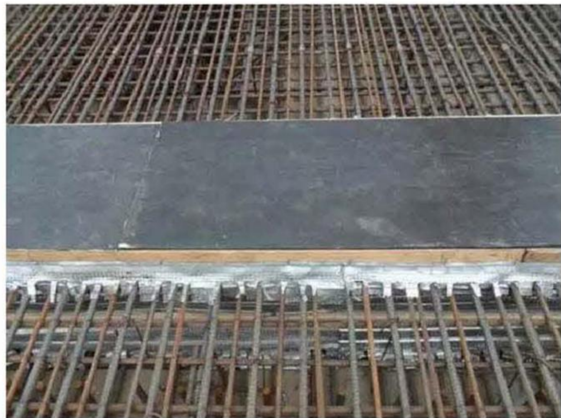
图6-36 后浇带保护盖板现场施工照片
