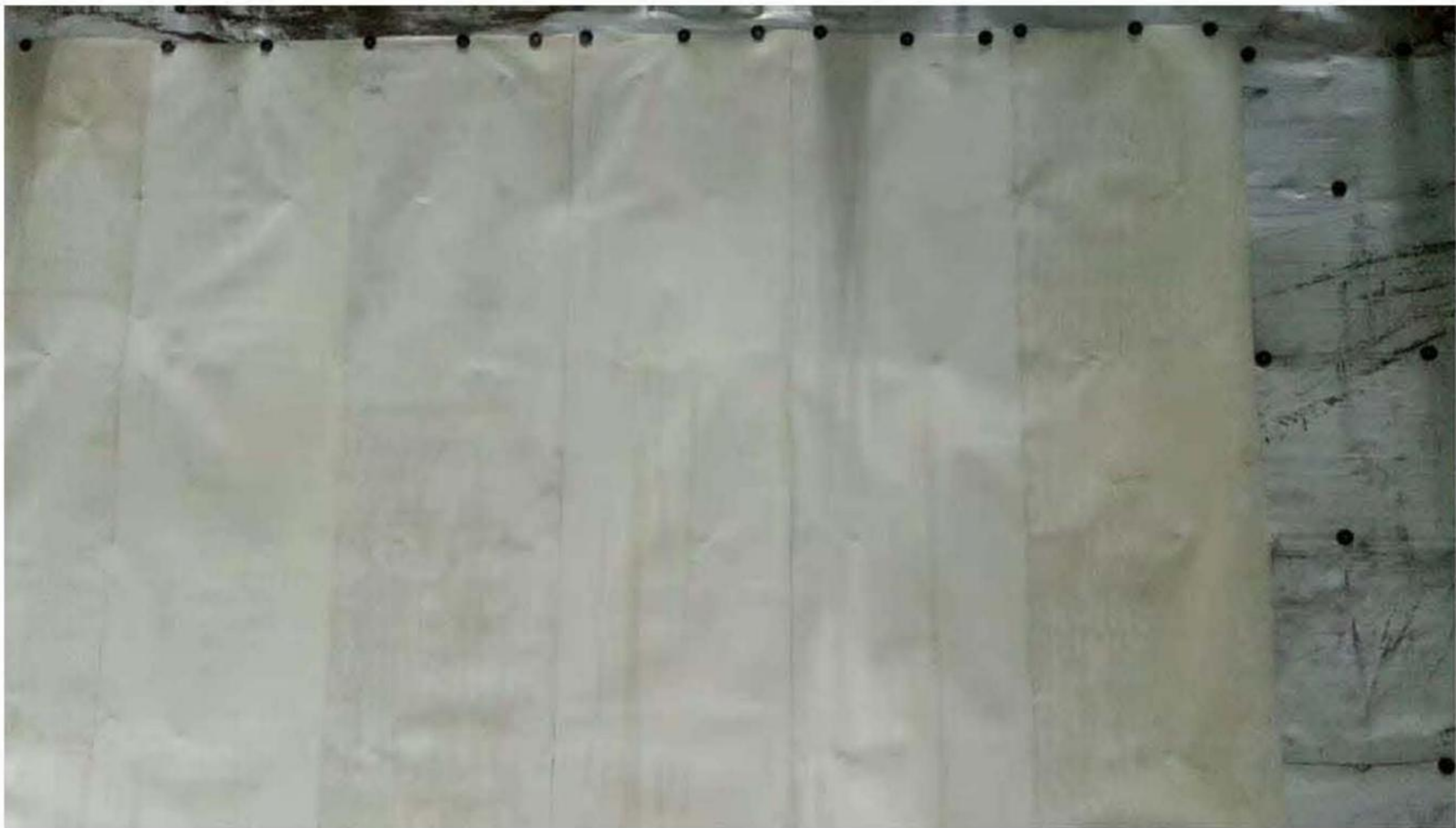
图5-29 高分子自粘胶膜预铺式防水层现场施工照片
