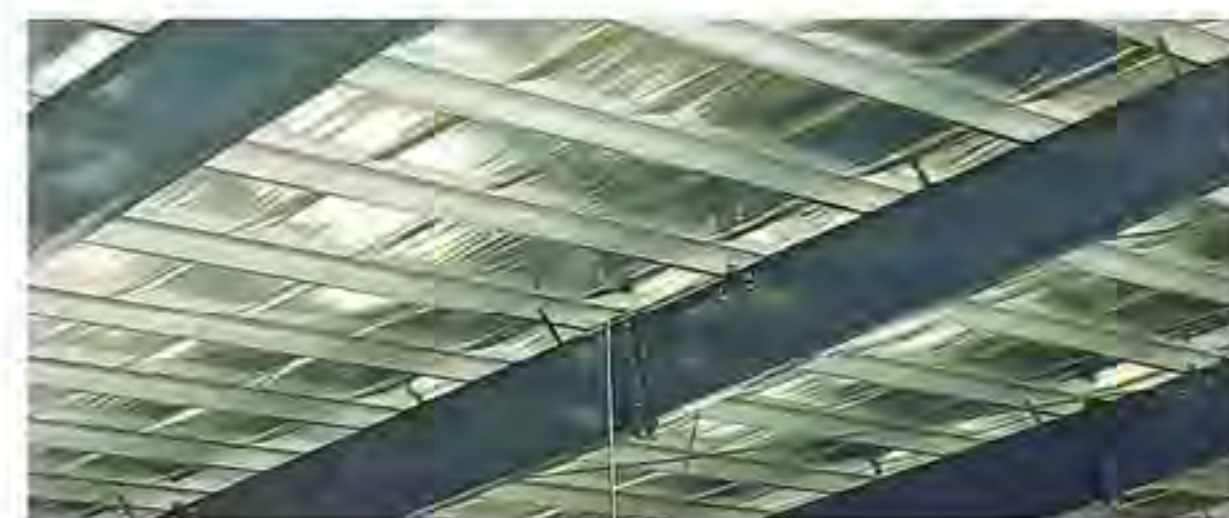
压型钢板保温屋面工程照片
