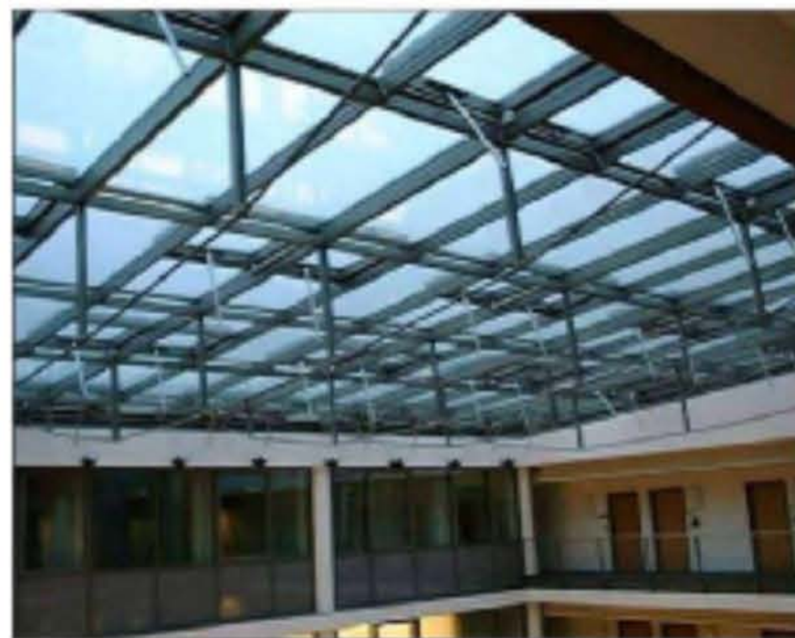
螺杆式开窗机用于采光屋面
