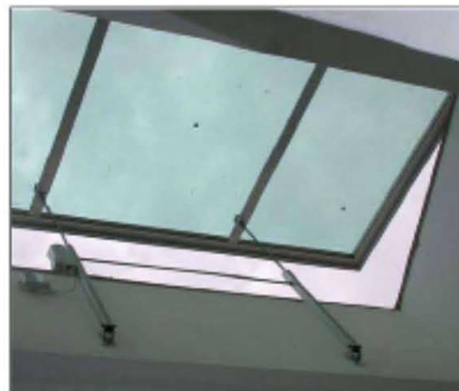
正辅杆齿条式开窗机用于屋面天窗
